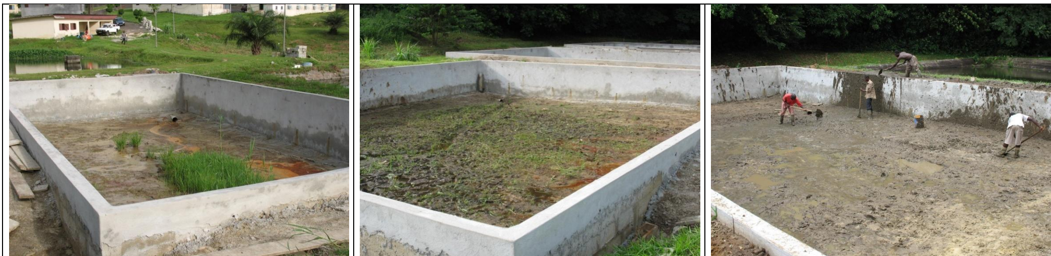
Canaux d'alimentation et d'évacuation réhabilités
